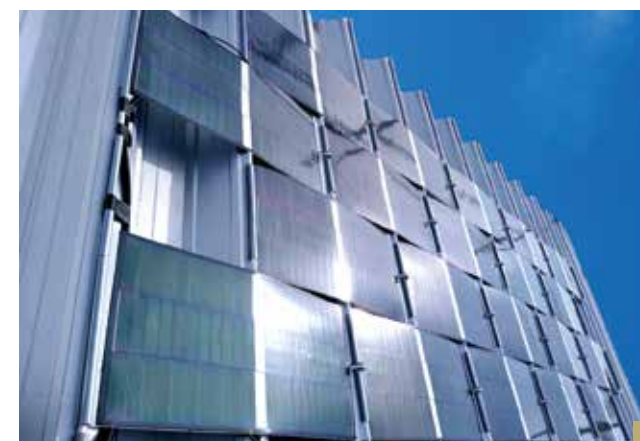
1 フィルム型の生産を可能にした製造装置 3 フィルム型カルコパイライト太陽電池を用いた大面積発電モジュールの実証実験
