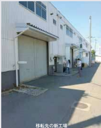
移転先の新工場
