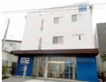
稼働した新施設
