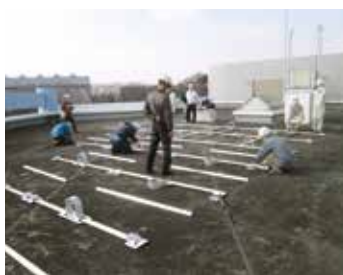
発電障がい者の就労施工風景
