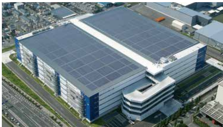
「ロジポート橋本」の屋根に設置された太陽光パネル
