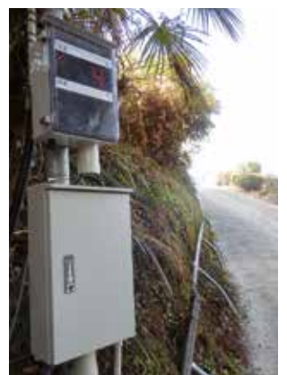
敷地内での実証実験の様子
