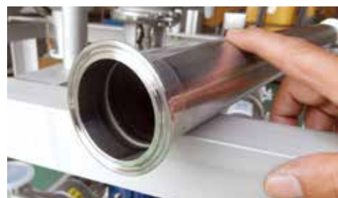
内側部分も溶接する技術
