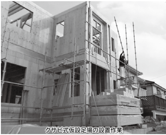
クサビ式仮設足場の設置作業
