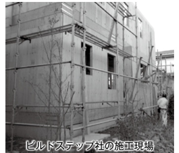
ビルドステップ社の施工現場
